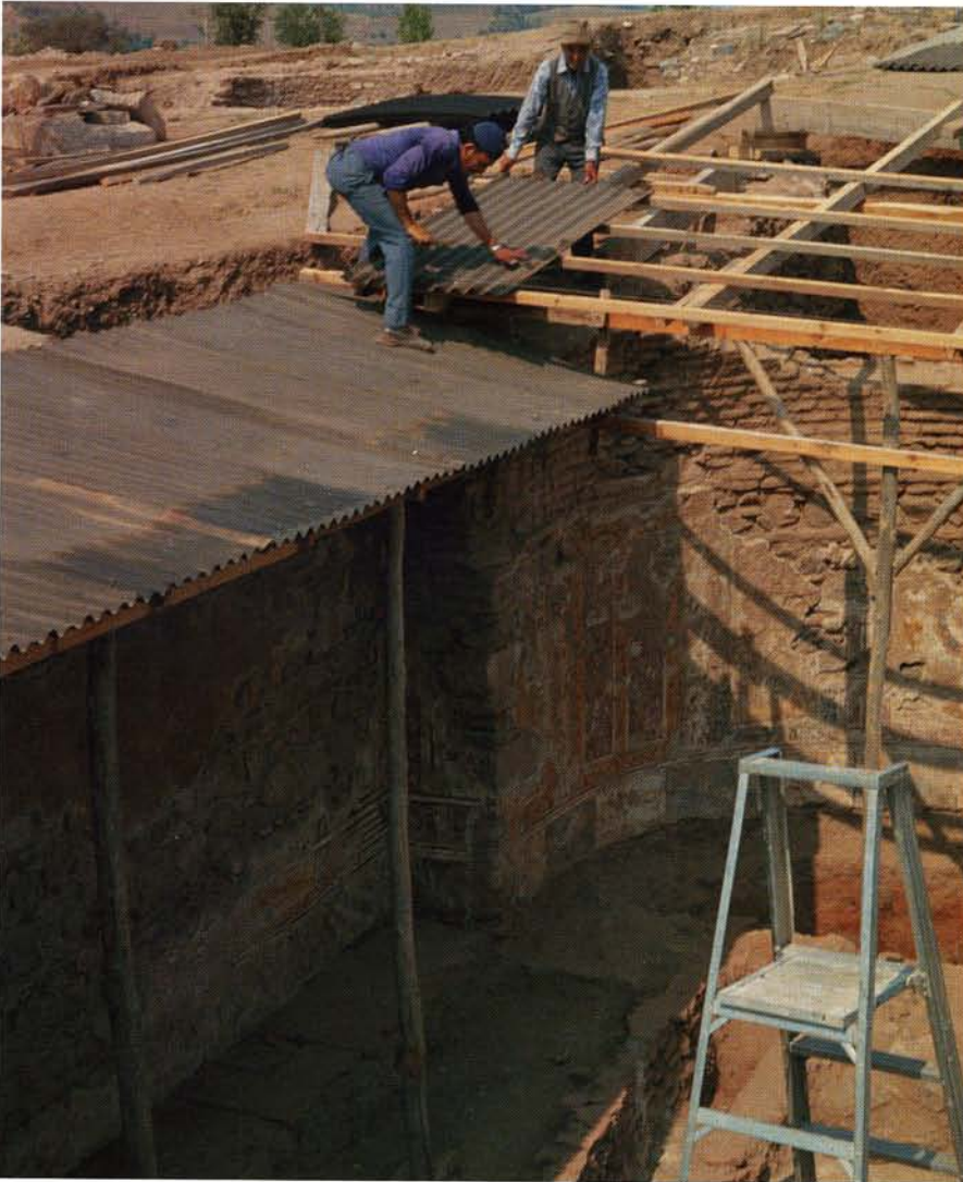
Figure 1: Temporary protective roof over excavations at Sardis, Turkey. Resim 1: Sardes kazı alanları üzerindeki geçici koruyucu çatı, Türkiye. Credit: Glenn Wharton
